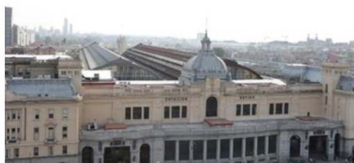
Fig. 2. Estación Mitre, Retiro (1915)
