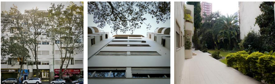
Fig. 13, 14, 15. Edificio Juramento Birabén, Lacalle Alonso (1937)
