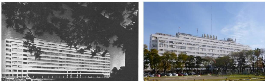
Fig 2. Hospital Bartolomé Churrua (1938-41, imagen de la izquierda reproducida de Nuestra Arquitectura, Diciembre 1941 e imagen de la derecha foto de la autora)
