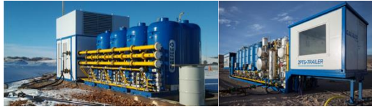
Figura 2. Planta ZPTS de acondicionamiento de gas
