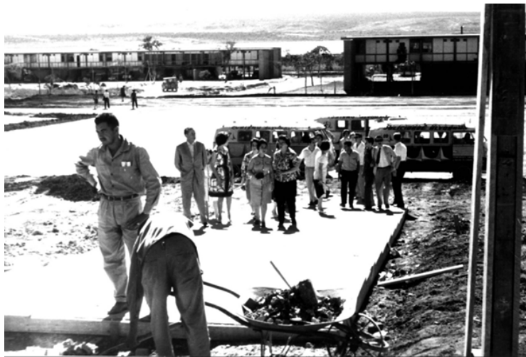
Fotografia 1: Oca em construção. Fonte CEDOC.
