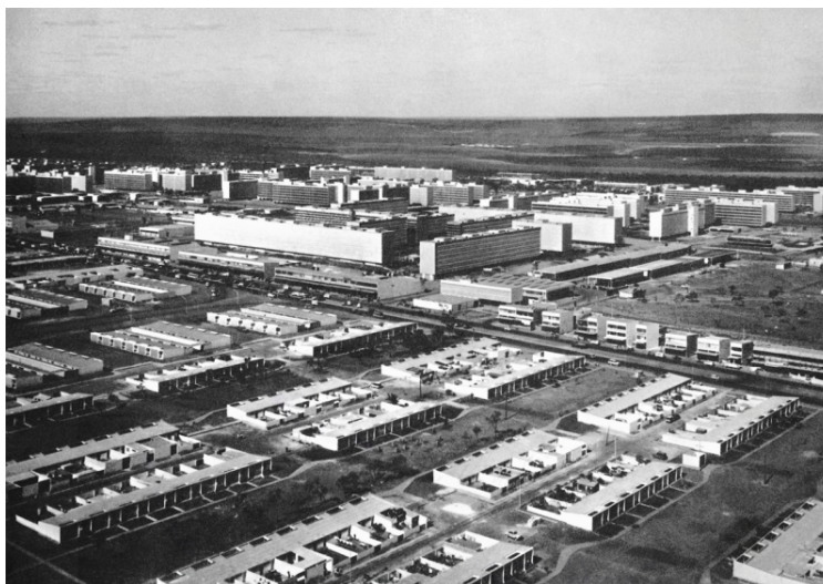
Fotografia 3: Vista aérea da asa sul em construção com as casas da W3 à frente e as superquadras ao fundo. Fonte: Plano Orientador da Universidade de Brasília, 1962.
