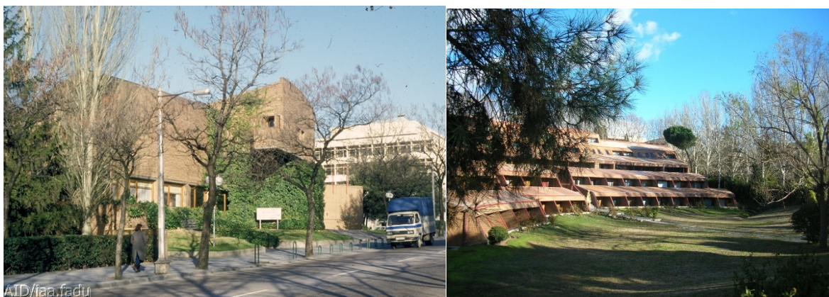
Fig. 13-14- Colegio Mayor Argentino en Madrid, fachada hacia la calle y hacia el patio interior. Fuente: 1. Archivo Imágenes Digitales IAA FADU UBA. 2. Eduardo Maestriperi
