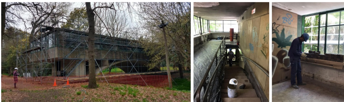
Fig. 27-29. Museo Casa sobre el Arroyo en Mar del Plata, restauración, 2021. Fotos: Mariana Quiroga
